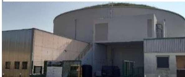
Restructuration du Hall D1-D2, de l'IGLOO, bat 201
