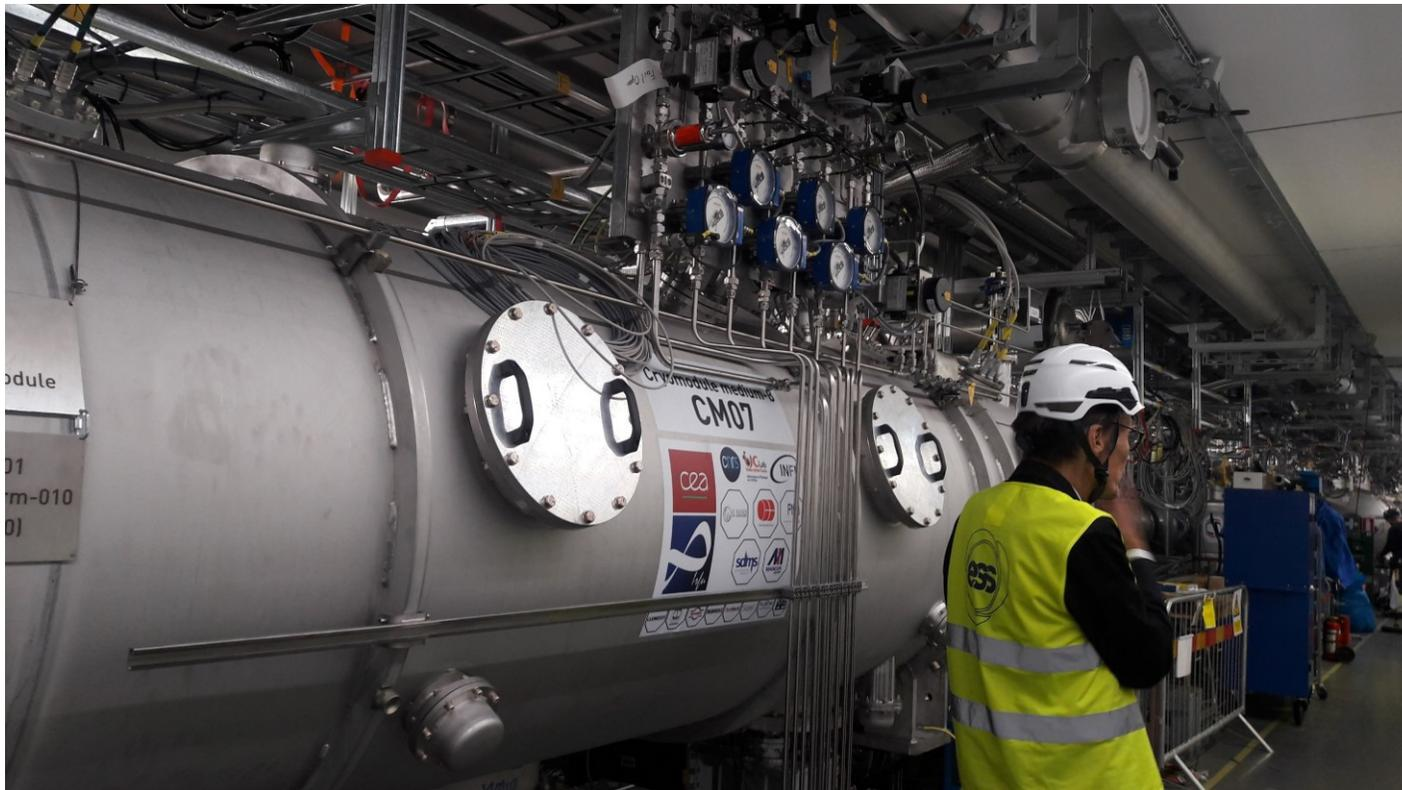
Cryomodule installé dans le linac
