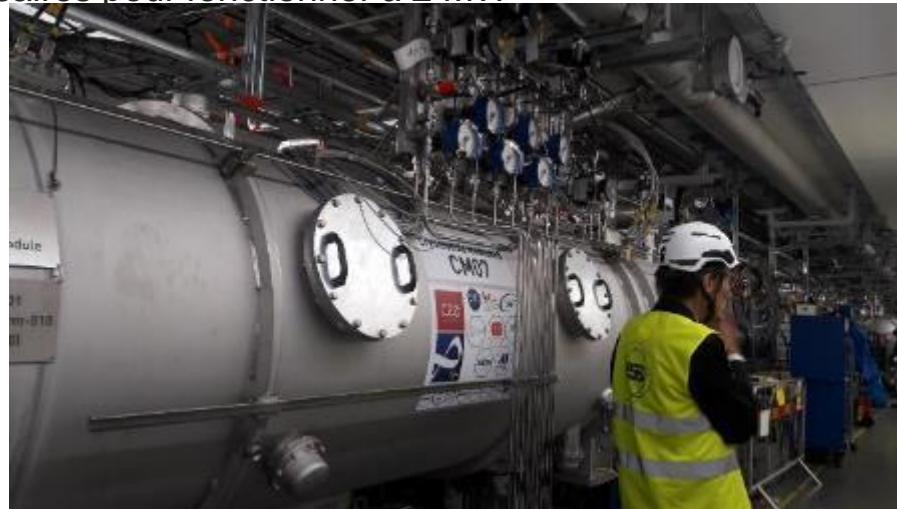
Le RFQ et un cryomodule installé dans le tunnel ESS
