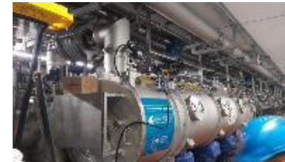
Premier CM installé dans le tunnel ESS
