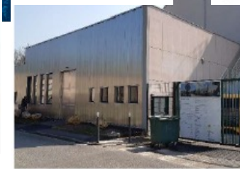
Hall D3-D4 Bâtiments 201
