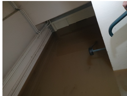
15h38 Porte d'accès galerie B200
