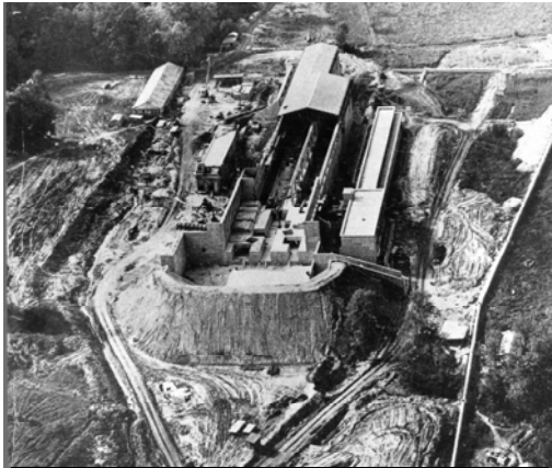
Chantier du LAL fin 1957
