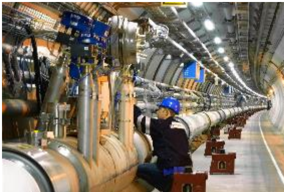
Ligne cryogénique avant la pose des aimants
