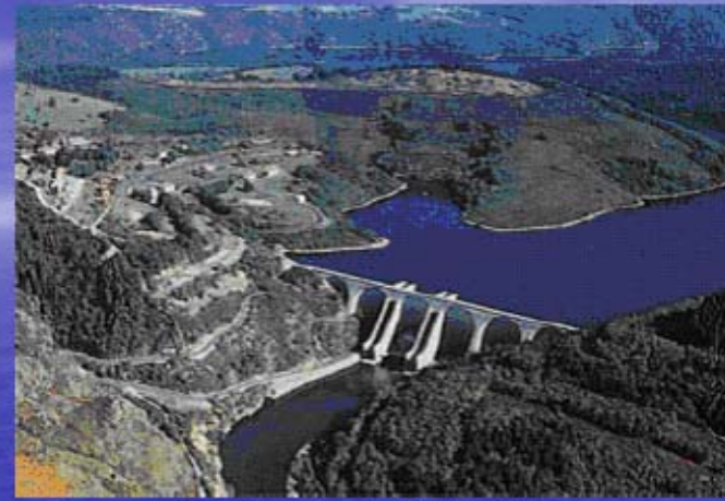
Barrage de Grandval - Usine de lac
