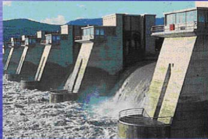
Barrage de Charmes - Usine d'éclusée
