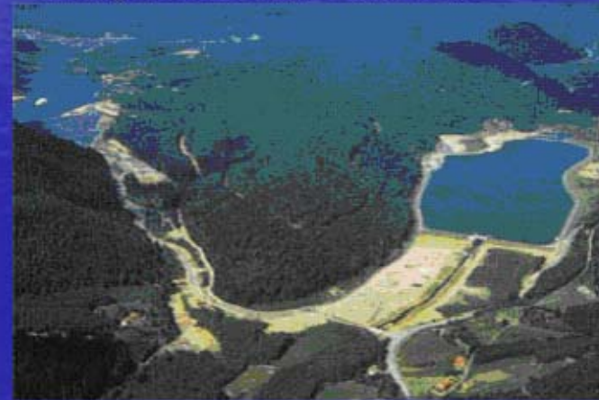
Usine de pompage du Vieux Pré
