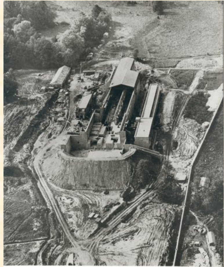
Vue aérienne du bâtiment de l'accélérateur linéaire à Orsay le 5 Octobre 1957
