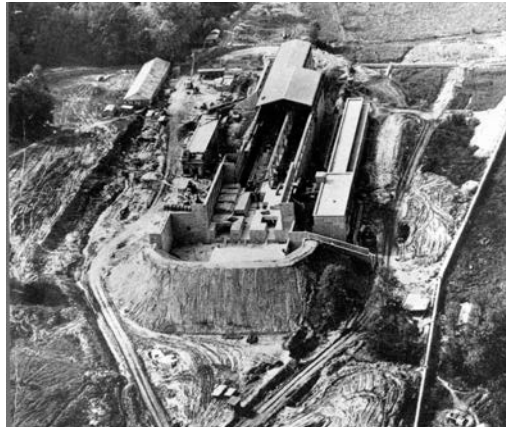
Chantier du LAL fin 1957
