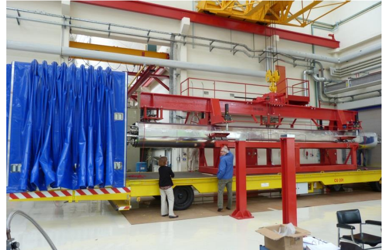
Transfert du cryomodule vers le hall enfourneur
