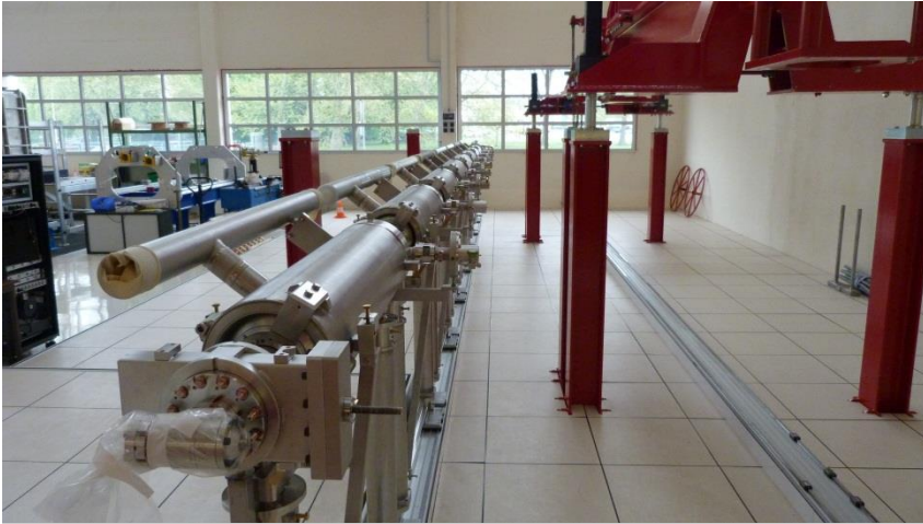
Roulage du train de cavités hors salle blanche
