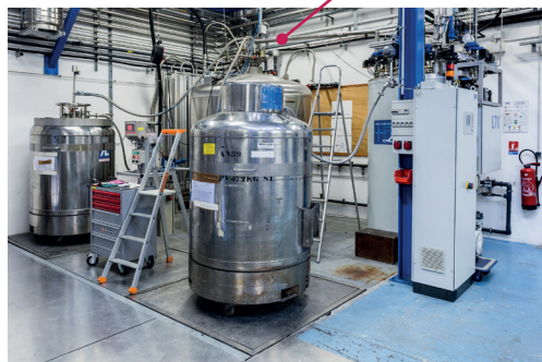
Installation d'hélium comprenant un liquéfacteur d'hélium et une installation de récupération et de compression associée ; ce gaz est soigneusement recyclé et reliquéfié.
