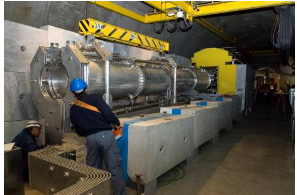
Mise en place de la corne CNGS
