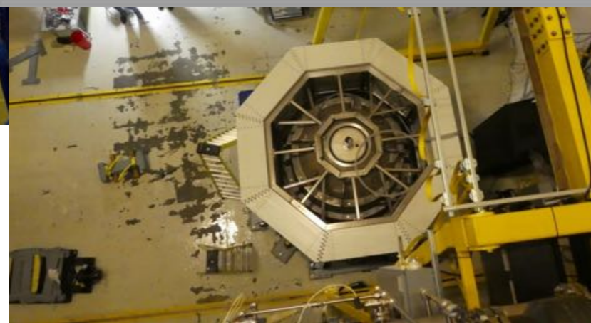
PE shielding installation
