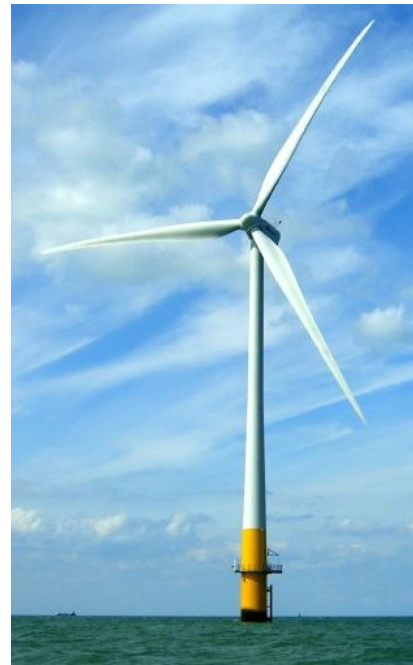
Eolienne Vestas V90-3MW
