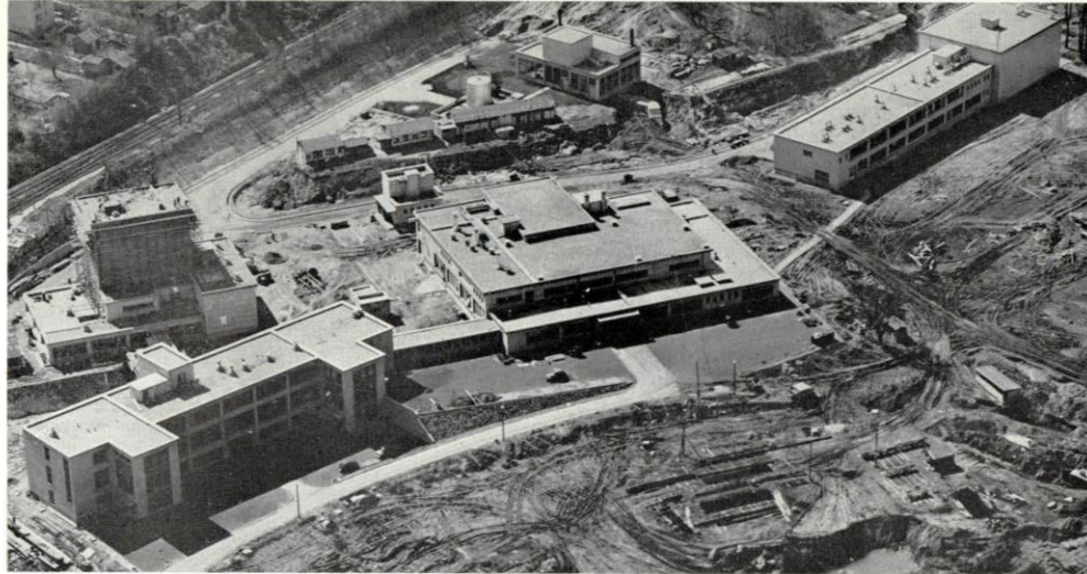
FIGURE 1. — Vue générale des bâtiments. Au fond, de gauche à droite : bâtiment des générateurs haute tension, tour de refroidissement eau du Synchrocyclotron et centrale de chauffage des bâtiments. Devant, de gauche à droite : séparation des isotopes, laboratoire de physique, bâtiment synchrocyclotron/cyclotron et bâtiment spectrographie \beta et \alpha .
